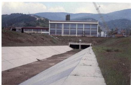
Slika 8. Odvodna vada
