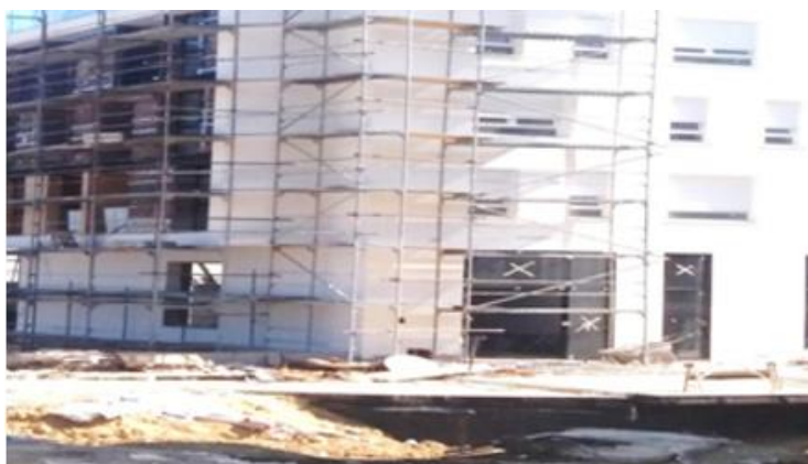
Slika 4. Loš primer montirane radne skele
