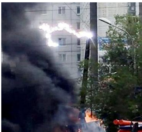
Slika 5. Indirektan dodir autodizalice sa elektromrežom
