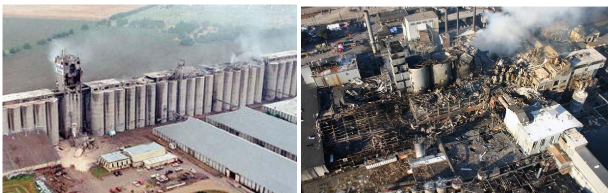
Slika 3. Izgoreli industrijski objekti kao posledica eksplozija na kofičastim elevatorima
