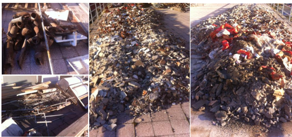
Slika 5. Građevinski otpad nastao prilikom rekonstrukcije sanitarnog dela objekta
