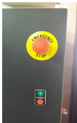
Slika 5: Upozoravajući znak na razvodnom ormanu dizalica u servisu
